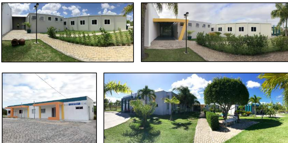
Figuras 102, 103, 104 e 105: Momentos antes e depois da instalação de marquise na entrada de funcionários do CEPS (superior), outras marquises construídas (inferior).
