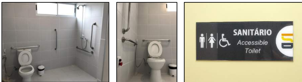
Figuras 86 e 87: Adequações nos banheiros para pessoas com deficiência.
