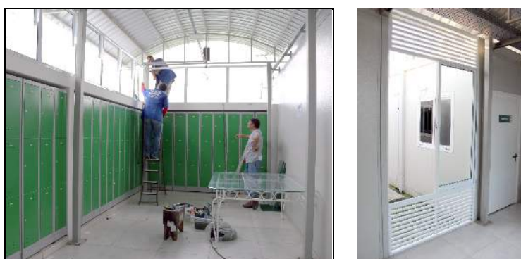
Figuras 108 e 109: Instalação de esquadrias de alumínio no prédio do CEPS.
