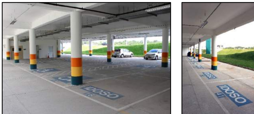
Figuras 84 e 85: Demarcações de vagas no subsolo do prédio do IIN-ELS.
