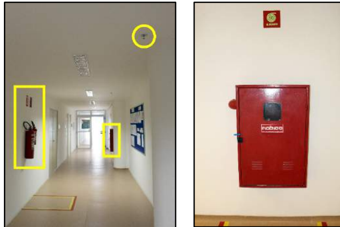
Figuras 82 e 83: Rede de sprinklers e outras adequações nas instalações de combate a incêndio.
