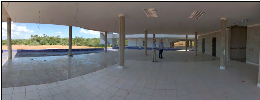
Figura 170: Refeitório do localizado no edifício do IIN-ELS.
