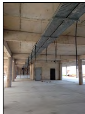
Figuras 160 e 161: Cobertura dos Shafts e eletrocalhas.
