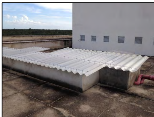
Figuras 160 e 161: Cobertura dos Shafts e eletrocalhas.
