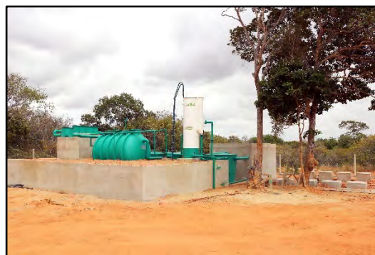
Figuras 166 e 167: Estação de tratamento de esgoto do edifício do IIN-ELS.
