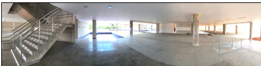
Figura 171: Subsolo do edifício do IIN-ELS
