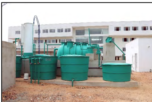
Figuras 166 e 167: Estação de tratamento de esgoto do edifício do IIN-ELS.
