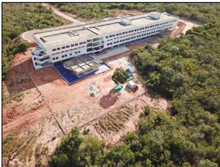
Figura 175: Vista aérea dos fundos do edifício do IIN-ELS (2017.)
