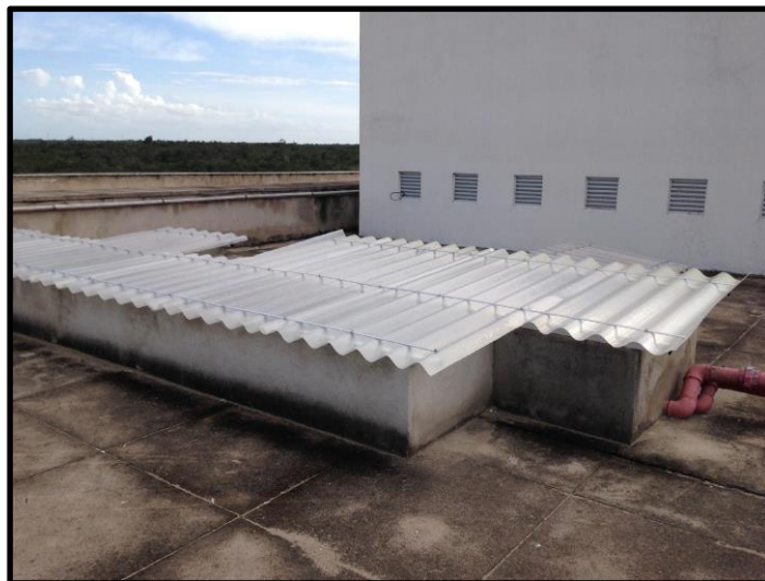
Figura 118: Cobertura dos Shafts.
