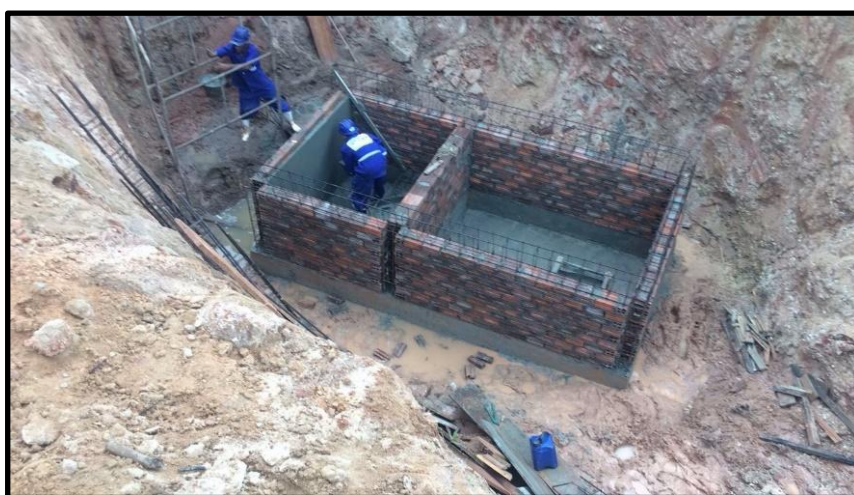
Figura 127: Estação elevatória da rede de esgoto.
