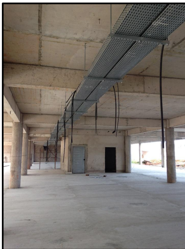
Figura 121: Eletrocalhas
