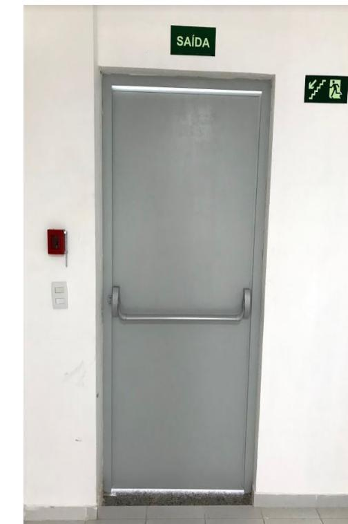
Figura 60 Substituição de sete (07) portas externas de vidro e alumínio do prédio do IIN-ELS por portas metálicas e cor-ta-fogo com barras antipânico
