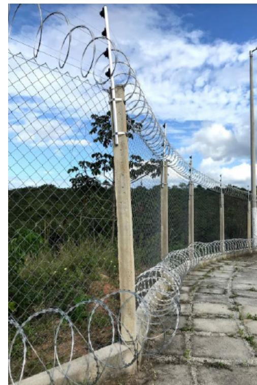
Figura 59 Instalação de 600 metros de cercas concertina dupla na parte inferior e 600 metros de concertina simples na parte superior protegendo todo o perímetro, além de 600 metros de cerca elétrica em toda a extensão do alambrado.
