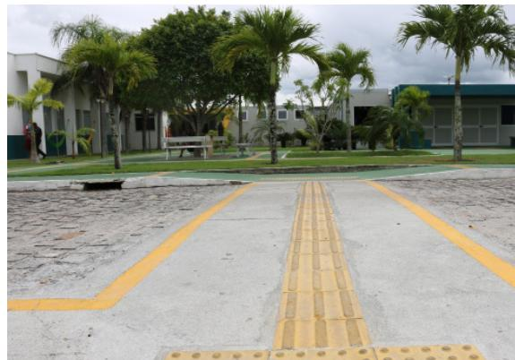
Figura 61 Construção e adequações de 240 m<sup>2</sup> de calçadas e 90 m de passeios adaptados para pessoas com deficiência e dificuldade de locomoção, atendendo à ABNT NBR 9050/2015 – Acessibilidade a edificações, mobiliário e equipamentos urbanos.
