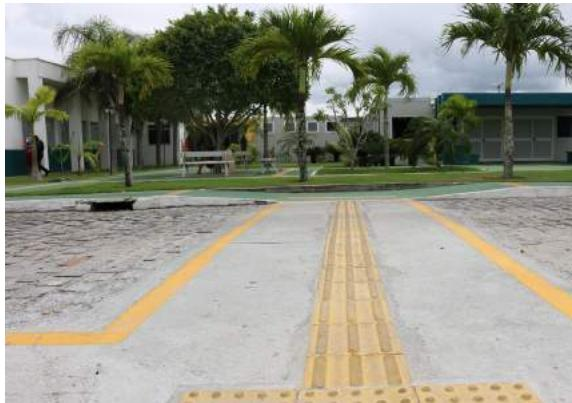
Figura 62: Construção e adequações de 240 m<sup>2</sup> de calçadas e 90 m de passeios adaptados para pessoas com deficiência e dificuldade de locomoção, atendendo à ABNT NBR 9050/2015 – Acessibilidade a edificações, mobiliário e equipamentos urbanos;
