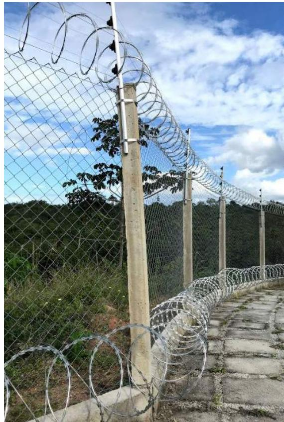
Figura 60: Instalação de 600 metros de cercas concertina dupla na parte inferior e 600 metros de concertina simples na parte superior protegendo todo o perímetro, além de 600 metros de cerca elétrica em toda a extensão do alambrado;
