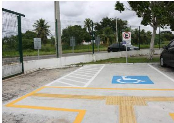
Figuras 63 e 64: Implantação de cinco (05) vagas de estacionamento adaptadas para PCD e 03 vagas para idosos conforme preconiza a ABNT NBR 9050/2015 – Acessibilidade a edificações, mobiliário e equipamentos urbanos.
