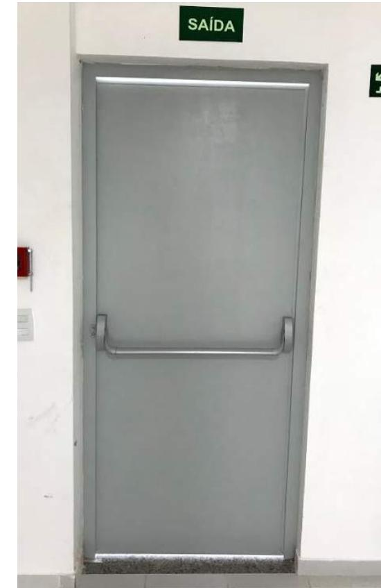
Figura 61: Substituição de sete (07) portas externas de vidro e alumínio do prédio do IIN-ELS por portas metálicas e corta-fogo com barras antipânico;
