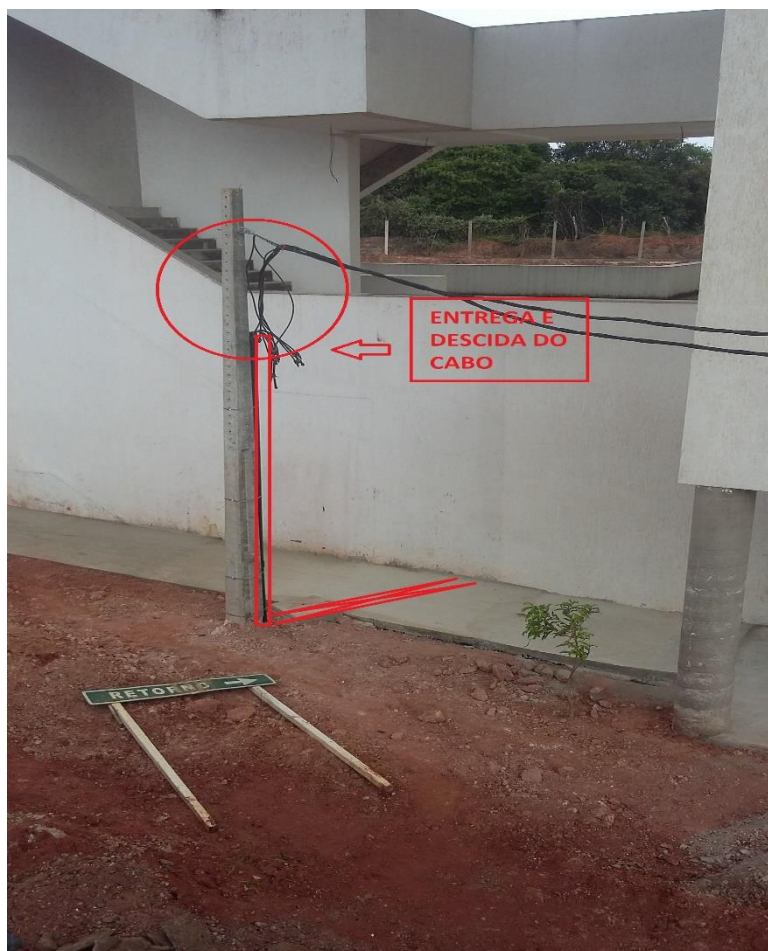
Tubulação de entrada dos cabos
