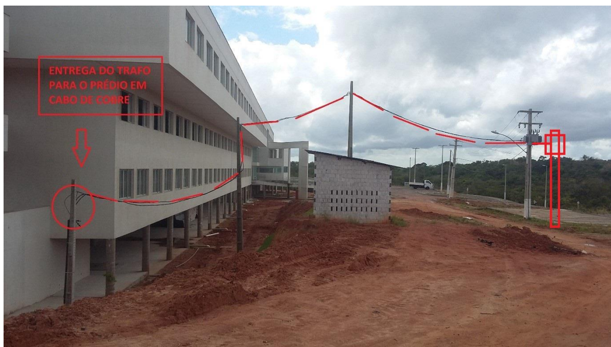
Imagem – 02 - Chegada do cabo até a entrada do prédio, para a ligação com cabo de cobre
