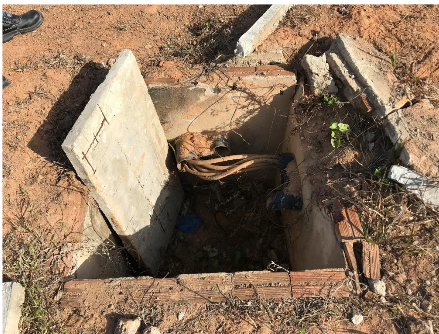
B - Caixa danificada, a ser reconstruída
