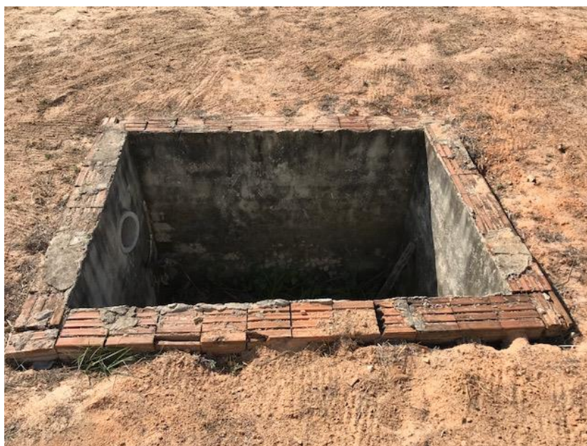
B - Caixa de Inspeção de drenagem para acabamento nas bordas, confecção e instalação de tampa de concreto armado
