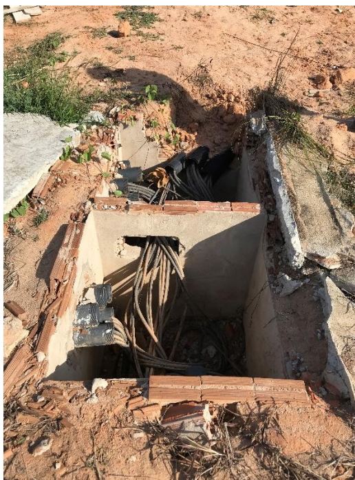
A - Caixa danificada, a ser reconstruída
